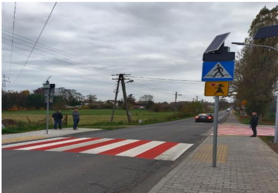
2022 r. „Przebudowa przejścia szkolnego na drodze powiatowej nr 1151E w Wiączyńiu Dolnym, gm. Nowosolna” Inwestor: Powiat Łódzki Wschodni Dofinansowanie: Rządowy Fundusz Rozwoju Dróg; Gmina Nowosolna
