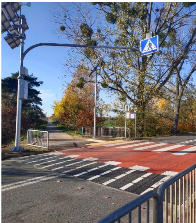
2022 r. „Budowa przejścia dla pieszych w drodze powiatowej nr 2917E w Stefanowie, gm. Koluszki Inwestor: Powiat Łódzki Wschodni Dofinansowanie: Rządowy Fundusz Rozwoju Dróg; Gmina Koluszki
