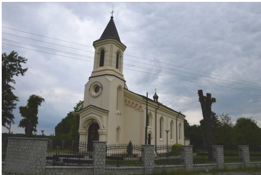
Fot. nr 6. Kościół w Galkowie Dużym pw. Św. Trójcy
