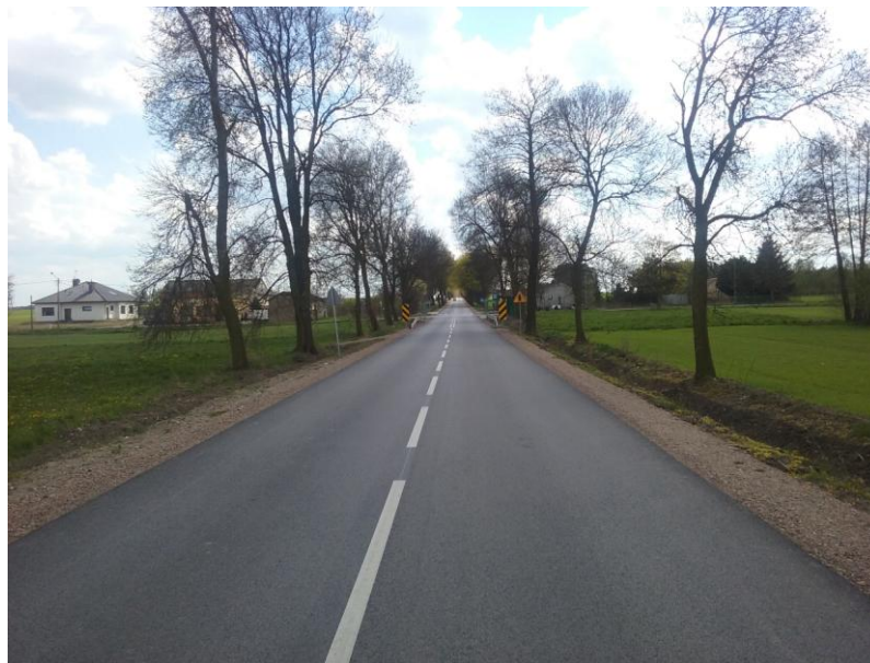
„Przebudowa odcinka drogi powiatowej nr 2930E w gminie Tuszyń” Inwestor: Powiat Łódzki Wschodni
