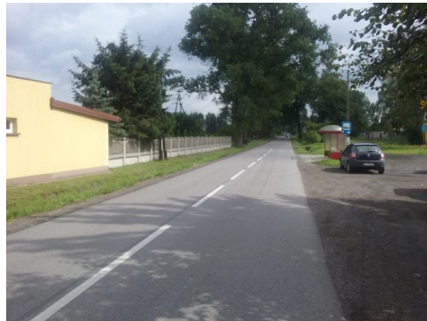
2015 r. – „Modernizacja drogi powiatowej Nr 2916E od drogi krajowej nr 71 do miejscowości Guzów” Inwestor: Gmina Rzgów
