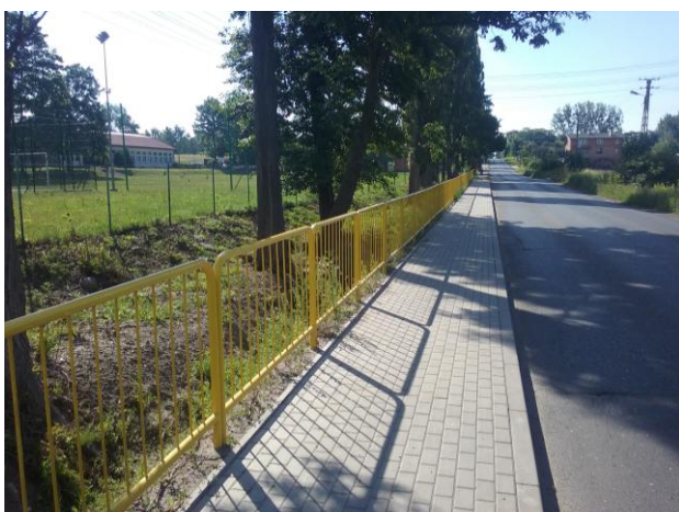
2015 r. - „Budowa chodnika przy drodze powiatowej nr 1151E i nr 2913E w miejscowości Wiączyń Dolny” Inwestor: Powiat Łódzki Wschodni
