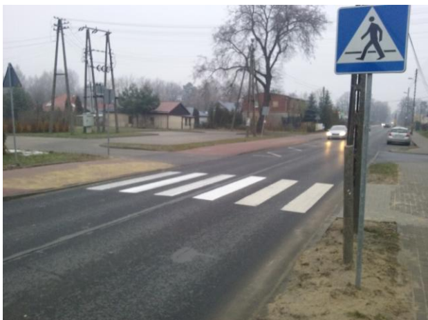
2015 r. - „Wykonanie przejścia dla pieszych na drodze powiatowej nr 2912E w rejonie ul. Oficerskiej w Wiśniowej Górze” Inwestor: Powiat Łódzki Wschodni
