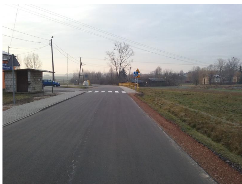
„Przebudowa drogi powiatowej Nr 2923E na odcinku z Wardzyna w kierunku Dalkowa” Inwestor: Powiat Łódzki Wschodni
