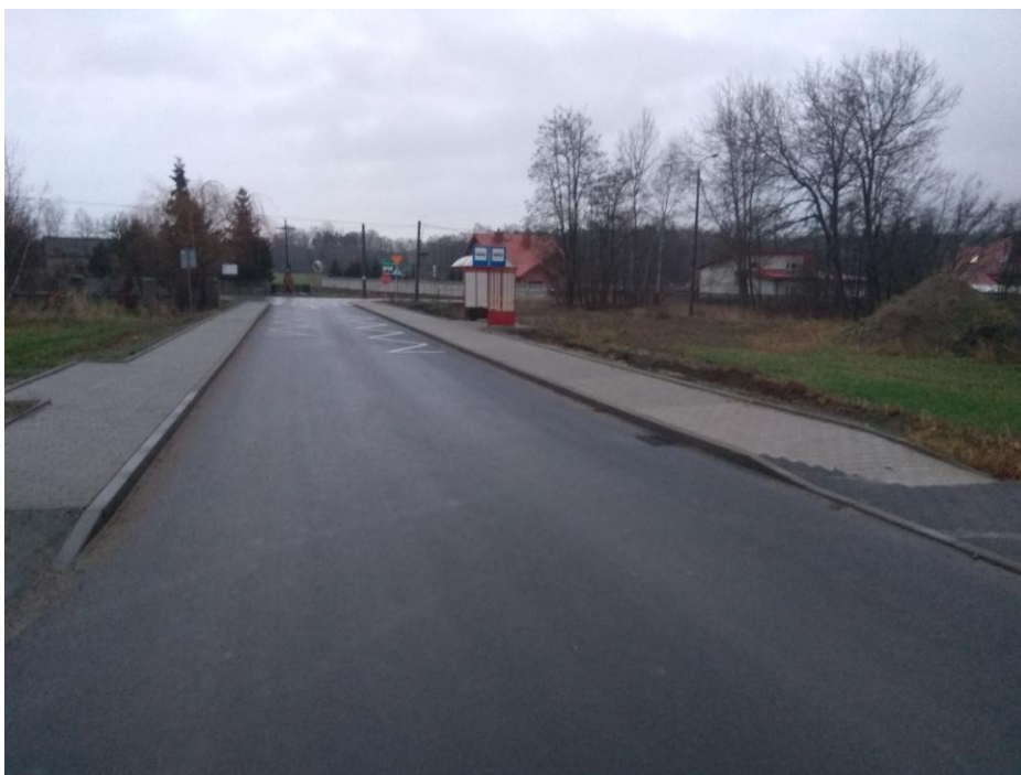
„Przebudowa drogi powiatowej Nr 2909E w Romanowie”
