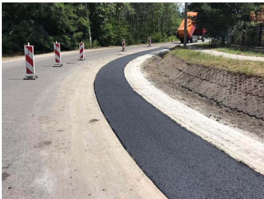
„Wykonanie wzmocnionego pobocza w łuku drogi powiatowej nr 2911E ul. Łódzkiej w Justynowie”
