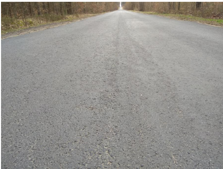
„Wykonanie nakładki bitumicznej na drodze powiatowej nr 2920E Budziszewice – Wola Łokotowa” (technologia slurry seal)
