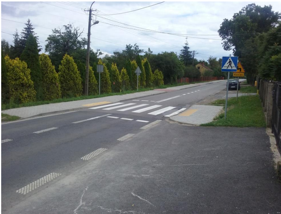
„Budowa chodnika do przejścia dla pieszych w drodze powiatowej nr 1151E w Wiączyńiu Dolnym”
